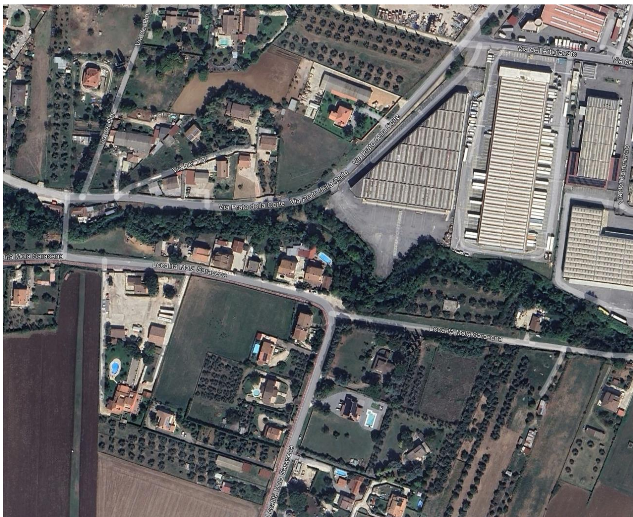
Fig. 2: Stato di Fatto
